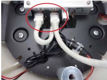
6. 本体内部に引き込み、給電ポートに接続します。 また、カメラ側のポートにもケーブルを接続しておきます。
